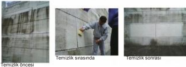
Fotoğraf 6. Fotokatalitik deterjan kullanılarak yapılan dış duvar temizliğinin sonucu.
